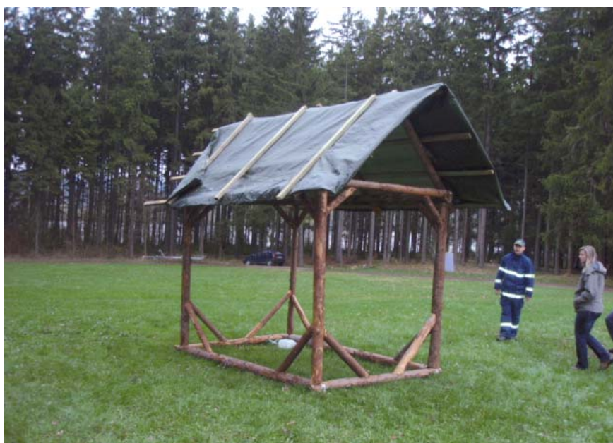
Obr. 87 Ilustrační foto z nácviu provizorního zastřešení
