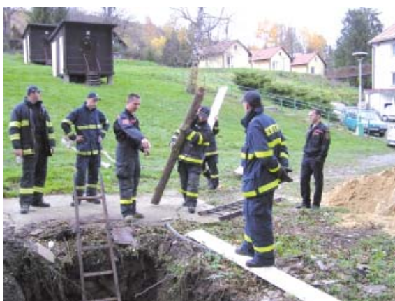
Obr. 84, 85 Ilustrační foto z nácviku zajištění výkopu
