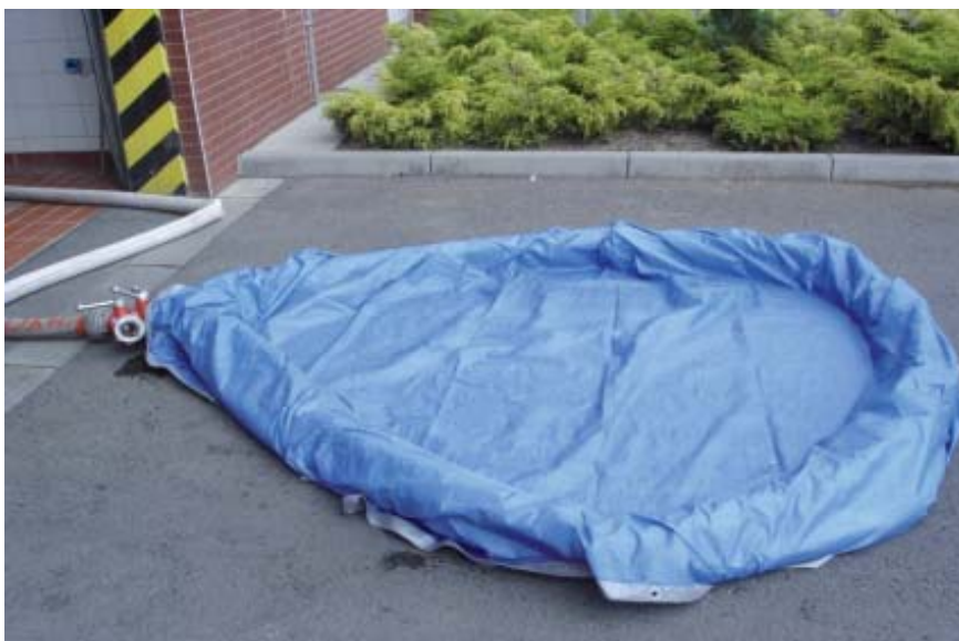
Obr. 53 Krok 4 vytváření dekontaminačního pracoviště
