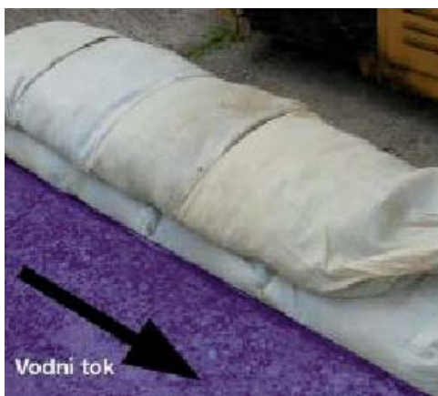
Obr. 7, 8 Způsob kladení jednokomorových pytlů (podélně, schématicky)
