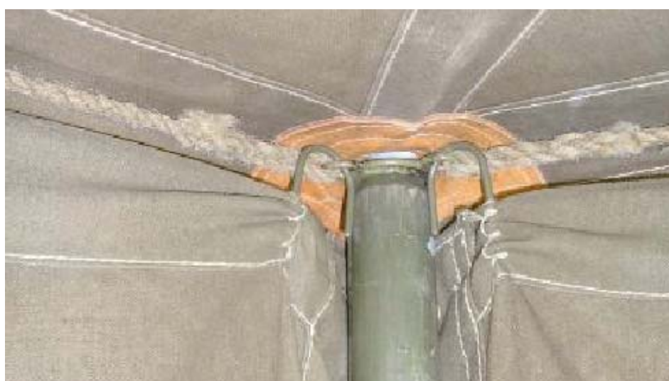
Obr. 35 Detail zavěšení bočních stěn u boční podpěry
