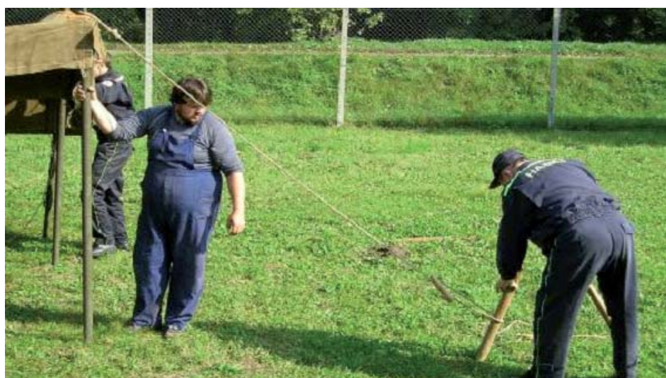
Obr. 33 Vypnutí stanu pomocí upínacího kolíku a lan
