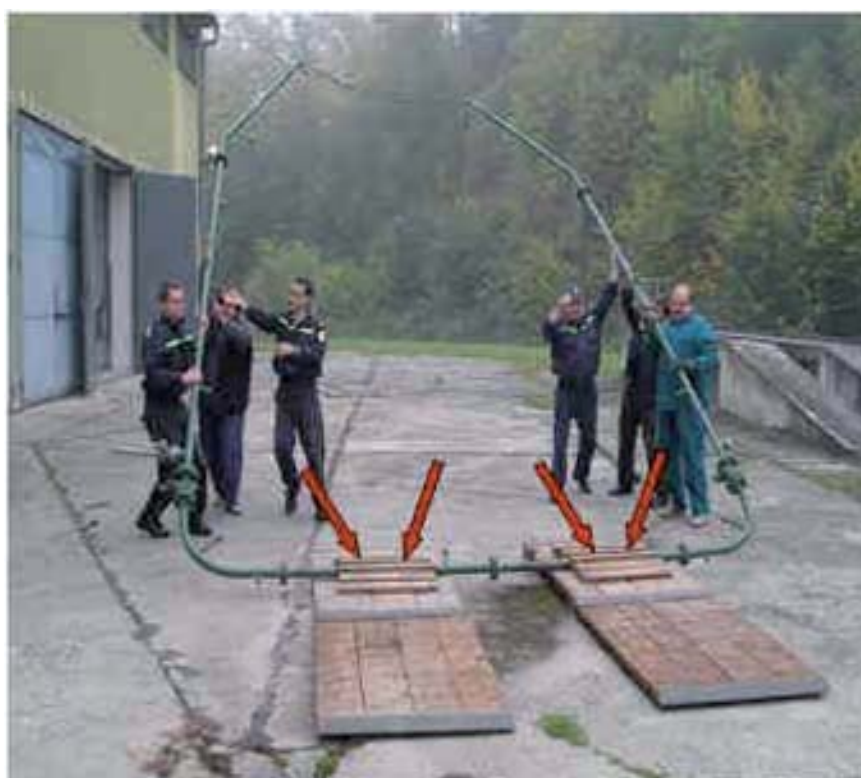
Obr. 74 Stavba mycího rámu
